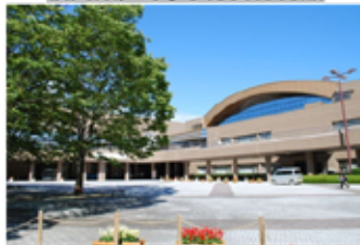
福島県/あづま総合体育館
